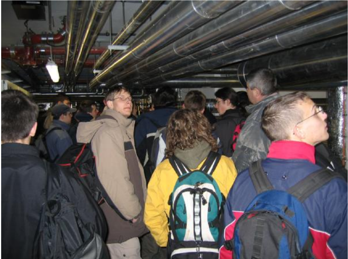
Technische Anlagen zur Wasseraufbereitung (TRIXI-PARK Zittauer Gebirge, Großschönau)
