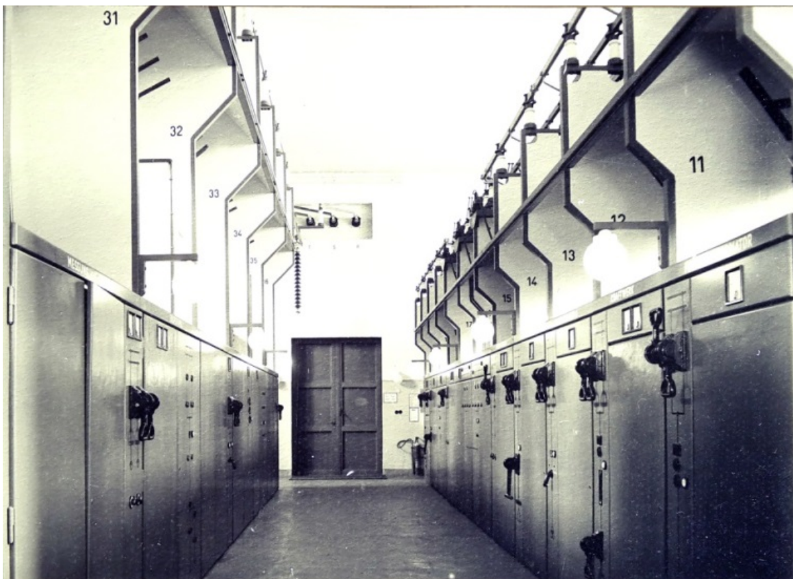
Bild 14: Luftisolierte Schaltanlage des Lehrumspannwerkes um 1965
