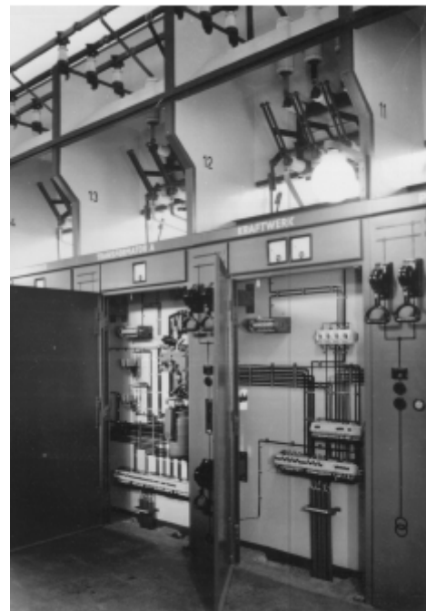
Bild 41: Schaltzellen mit geöffneten Nischenschränken
