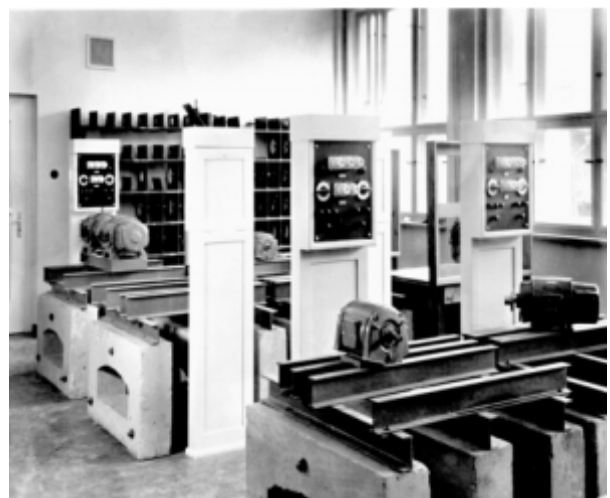
Bild 24: Labor für elektrische Maschinen
