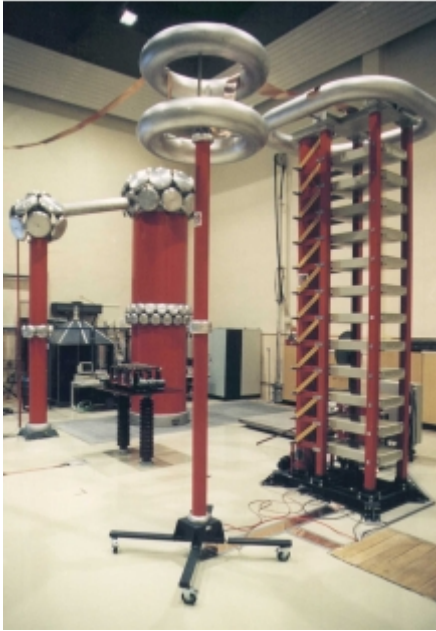
Bild 116: Neue Impulsspannungsprüfanlage 1,2 MV/ 60 kJ in der Hochspannungshalle (HIGHVOLT Dresden)
