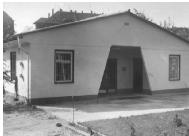
Bild 76b: Gebäude des Applikationslabors Mikroelektronik - nach Fertigstellung -
