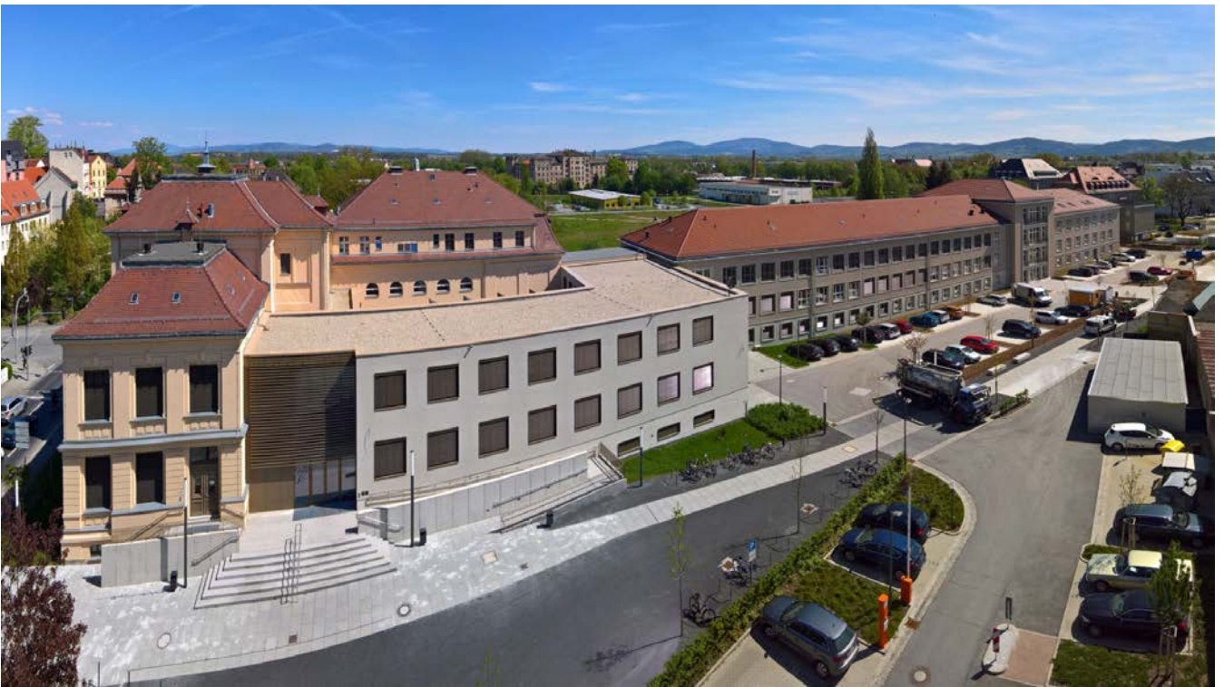
Bild 21b: Blick auf das sanierte Haus Z I (Aufnahmedatum: 11.05.2017)
