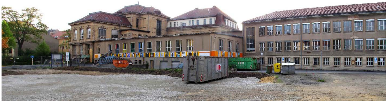
Bild 141: Haus I und Laborsaal vor Beginn der Sanierung
