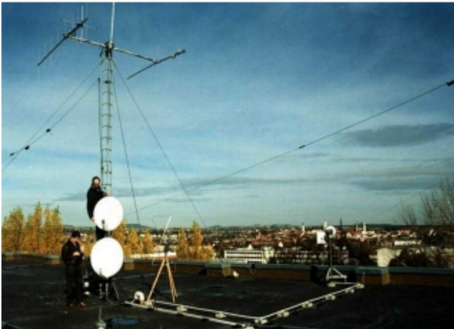
Bild 124: Antennenanlage auf dem Dach von Haus VII mit Blick auf Zittau
