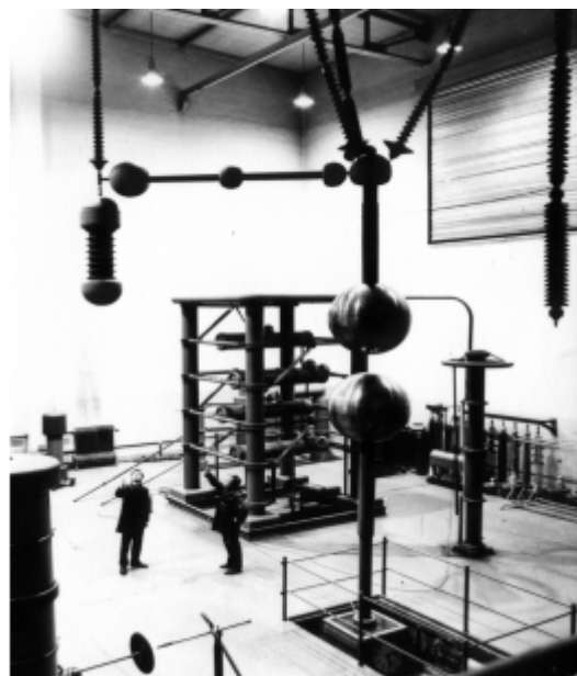
Bild 44: Stoßanlage mit Kugelfunkenstrecke
