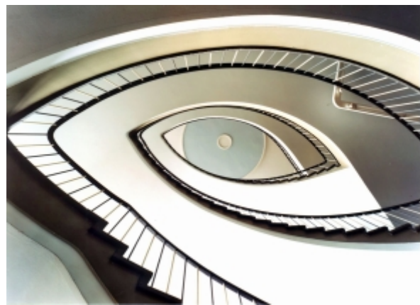
Bild 48: Blick aus dem Kellergeschoss nach oben durch die Treppe im Eingangsflügel
