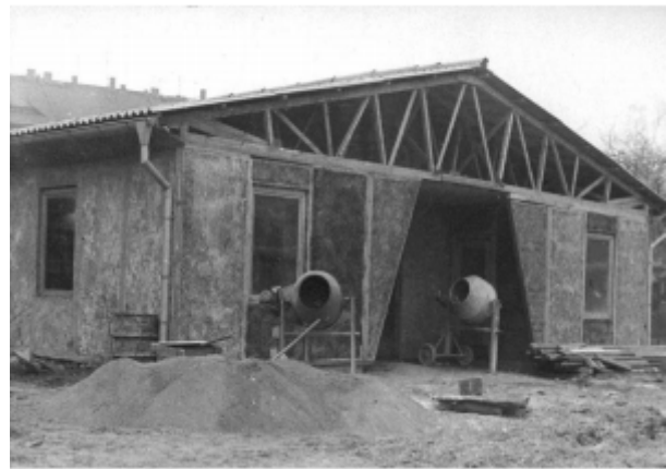
Bild 76a: Gebäude des Applikationslabors Mikroelektronik - in der Bauphase -
