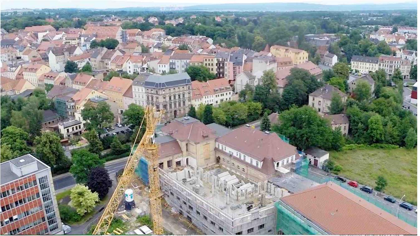
Bild 21a: Aufbau des Ersatzneubaues in Fertigteilbauweise (Aufnahmedatum: 26.06.2014)
