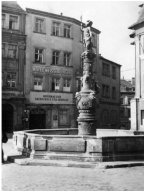
Bild 25: Erstes Internat am Markt
