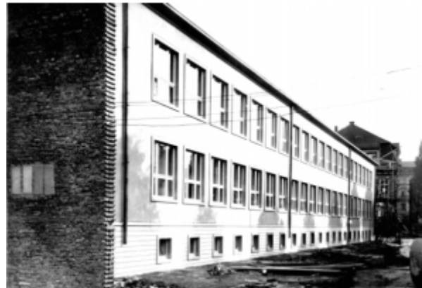
Bild 37: Erster Erweiterungsbau der Fachschule als Anbau in südwestlicher Richtung
