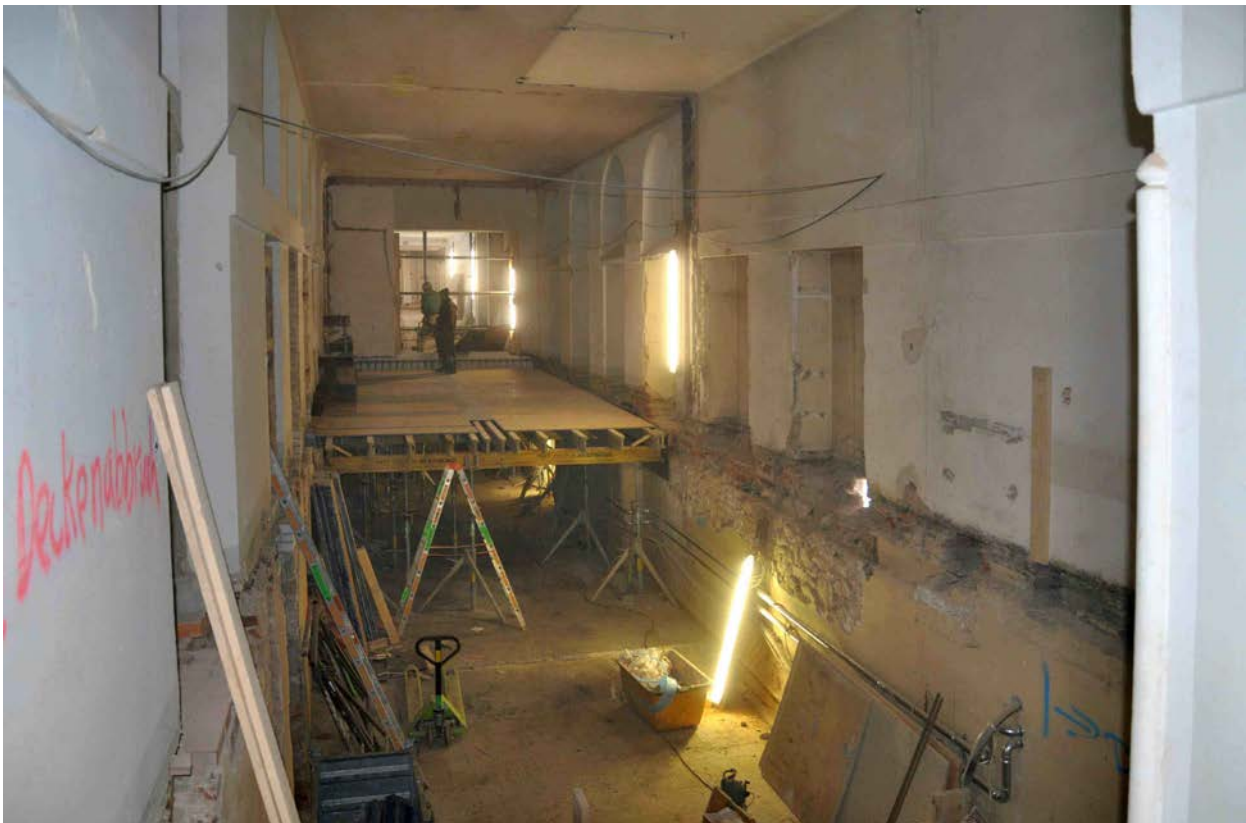
Bild 20: Nach dem Ausbau der Holzbalkendecke im Altbau wird die Schalung für die neue Betondecke vorbereitet (Aufnahmedatum: 24.01.2014)
