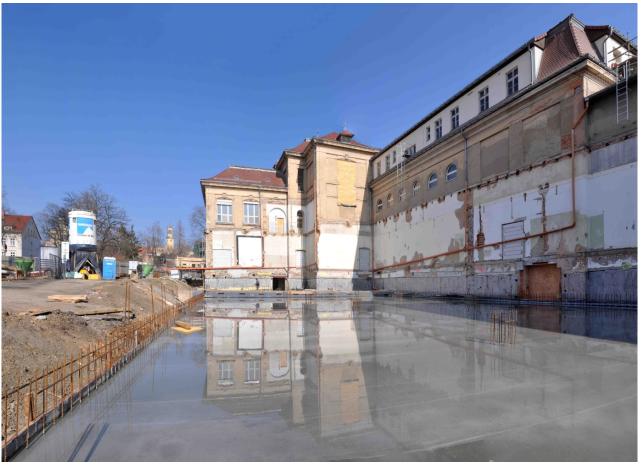
Bild 19: Die frisch gegossene Bodenplatte für den Ersatzneubau (Aufnahmedatum: 07.03.2014)
