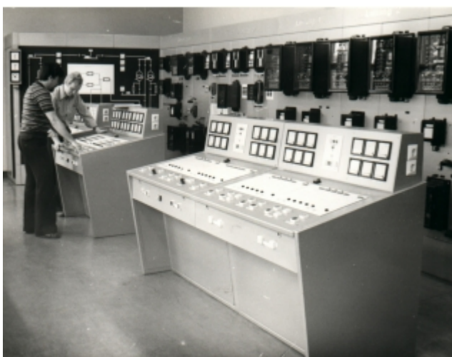
Bild 72: Versuchsaufbauten im Schutztechnik-Labor II
