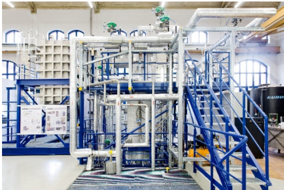
Bild 164: Thermische Energiespeicheranlage THERESA
