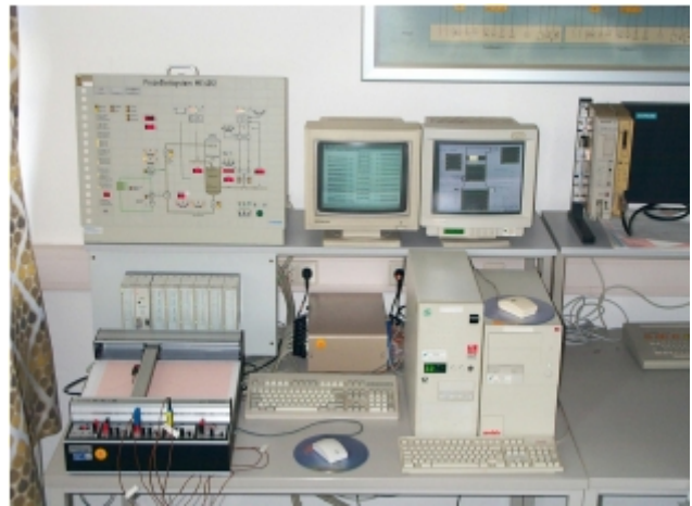
Bild 107: Versuchsstand „Optimale Steuerung einer Rauchgasentschwefelungsanlage realisiert mit Leittechnik der Firma Helmut Mauell GmbH
