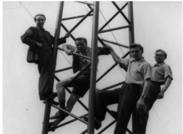
Bild 52: Studenten bei einer Exkursion im Umspannwerk „Glück Auf“ im August 1955
