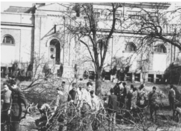
Bild 26: Arbeitseinsatz zur Beräumung des Geländes vor dem alten Websaal
