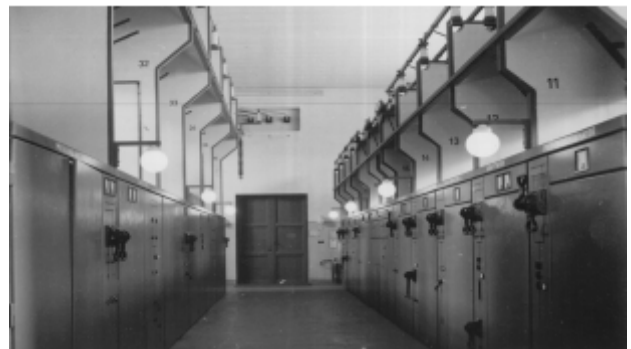
Bild 40: Blick in die Innenraumschaltanlage
