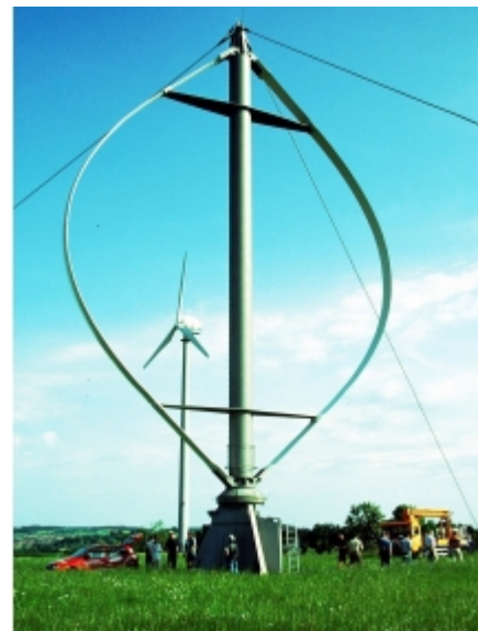
Windkraftanlage der En BW AG
