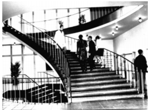
Bild 47: Treppe im Eingangsflügel der Ingenieurschule
