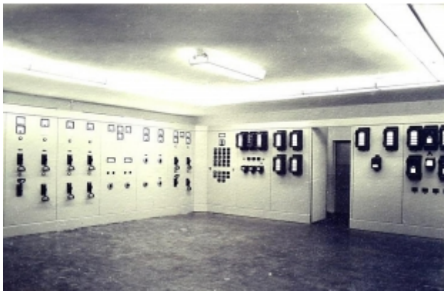
Bild 42: Die Schalt- und Schutzwanne des Lehrumspannwerkes
