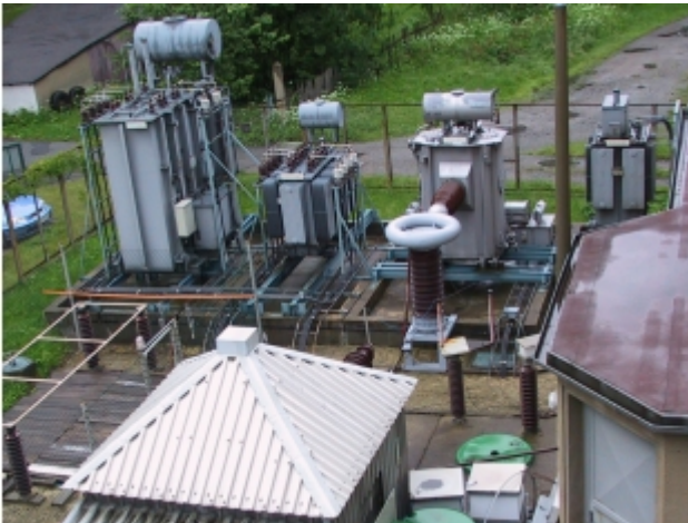
Bild 69: Freiluftversuchsanlage für die Fremdschichtforschung
