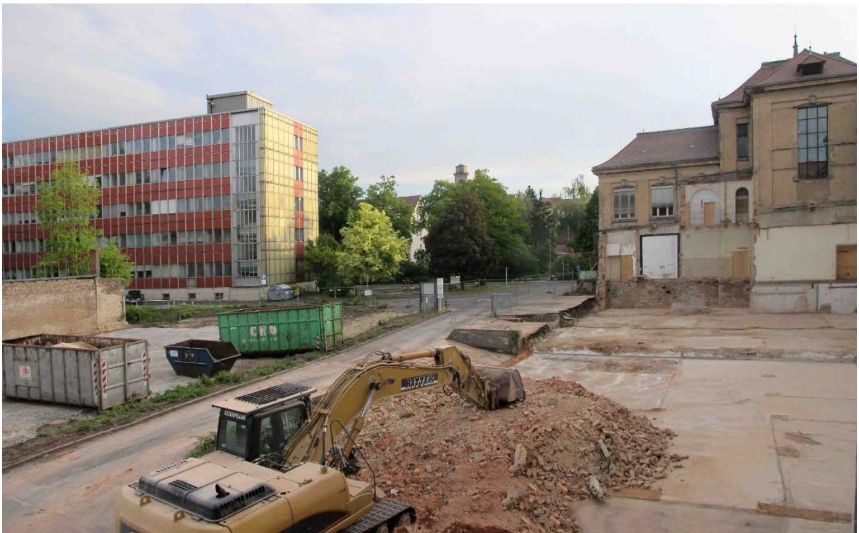
Bild 142: Nach dem Abriss des Laborsaaes
