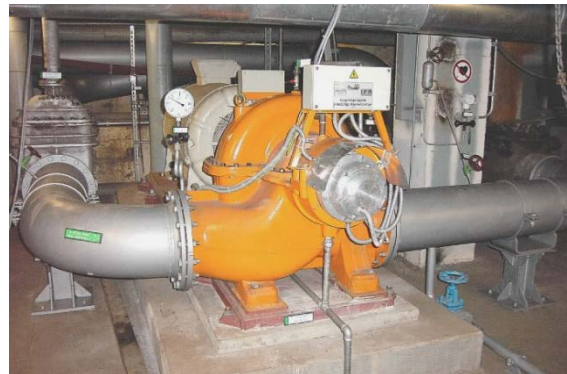
Bild 157: Magnetgelagerte Pumpe im Kraftwerk Boxberg
