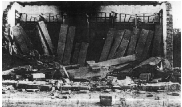
Bild 50: Station Olbersdorf Grube nach der Zerstörung
