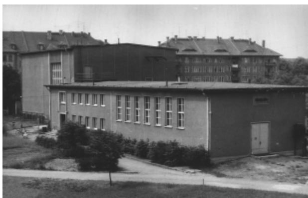
Bild 43: Lehrumspannwerk mit beiden Ausbaustufen und anschließender Hochspannungshalle
