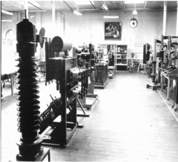
Bild 49: Labor für elektrische Apparate
