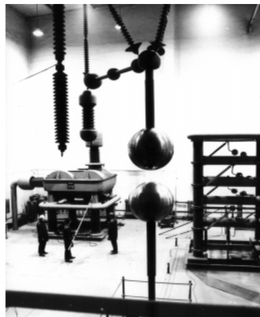
Bild 45: Wechselspannungstransformator, im Vordergrund die Kugelfunkenstrecke
